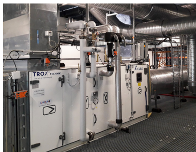
Traitement d'air et dépeussierage d'un nouvel atelier de cosmétique blanche
